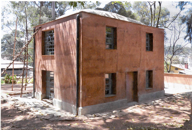
SUDU steht für Sustainable Urban Dwelling Unit: eine einfache Hütte, konstruiert aus Stampflehm und Lehmziegeln, mit gewölbtem Dach. Foto: Marta H. Wisniewska
