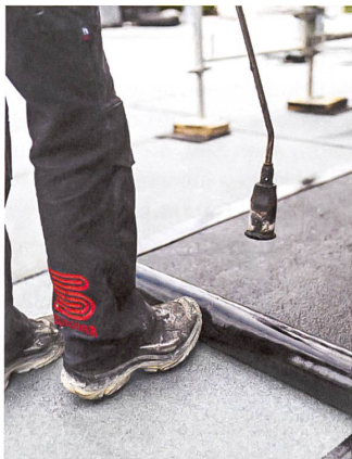
Ein Mitarbeiter verschweisst auf einem Flachdach Bitumenbahnen.
