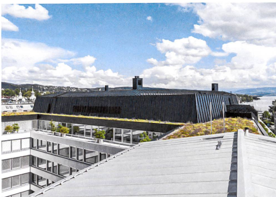
Das neue Dach: Ein Aufbau aus anodisiertem Aluminium umgibt den Lichthof, begrünte Schenkel die Tiefenhöfe.
