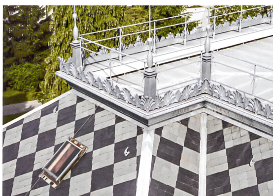
Rekonstruiertes Dach, 2013: Schieferplatten in zwei Farben und 385 Blätterornamente aus Titanzink krönen die Villa erneut.
