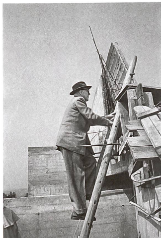
Le Corbusier auf der Baustelle La Tourette in Eveux-sur-l'Arbresle, 1959.
