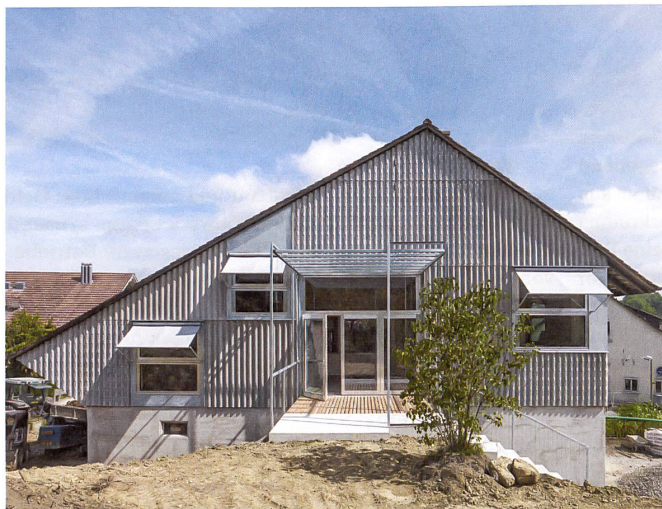
Ländliche Materialien in Iberg bei Winterthur: In der Eternitverkleidung sind die verzinkten Fenster frei verteilt. Aussparungen bringen Licht in die unbeheizten Bereiche.
