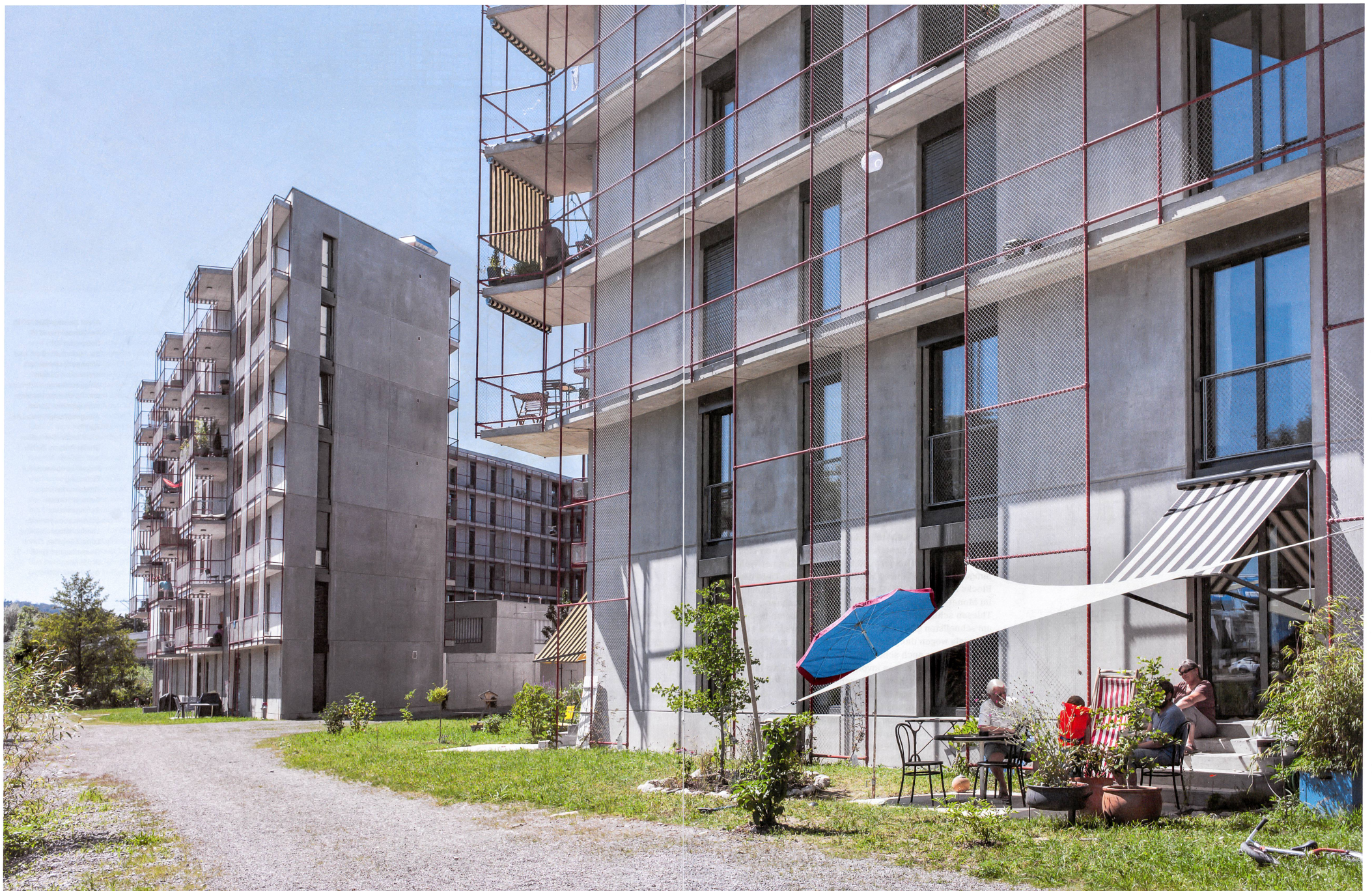
Zwicky-Areal zwischen Dübendorf und Wallisellen: Auf der Südseite öffnen sich die Erdgeschosswohnungen zum Grünraum.
