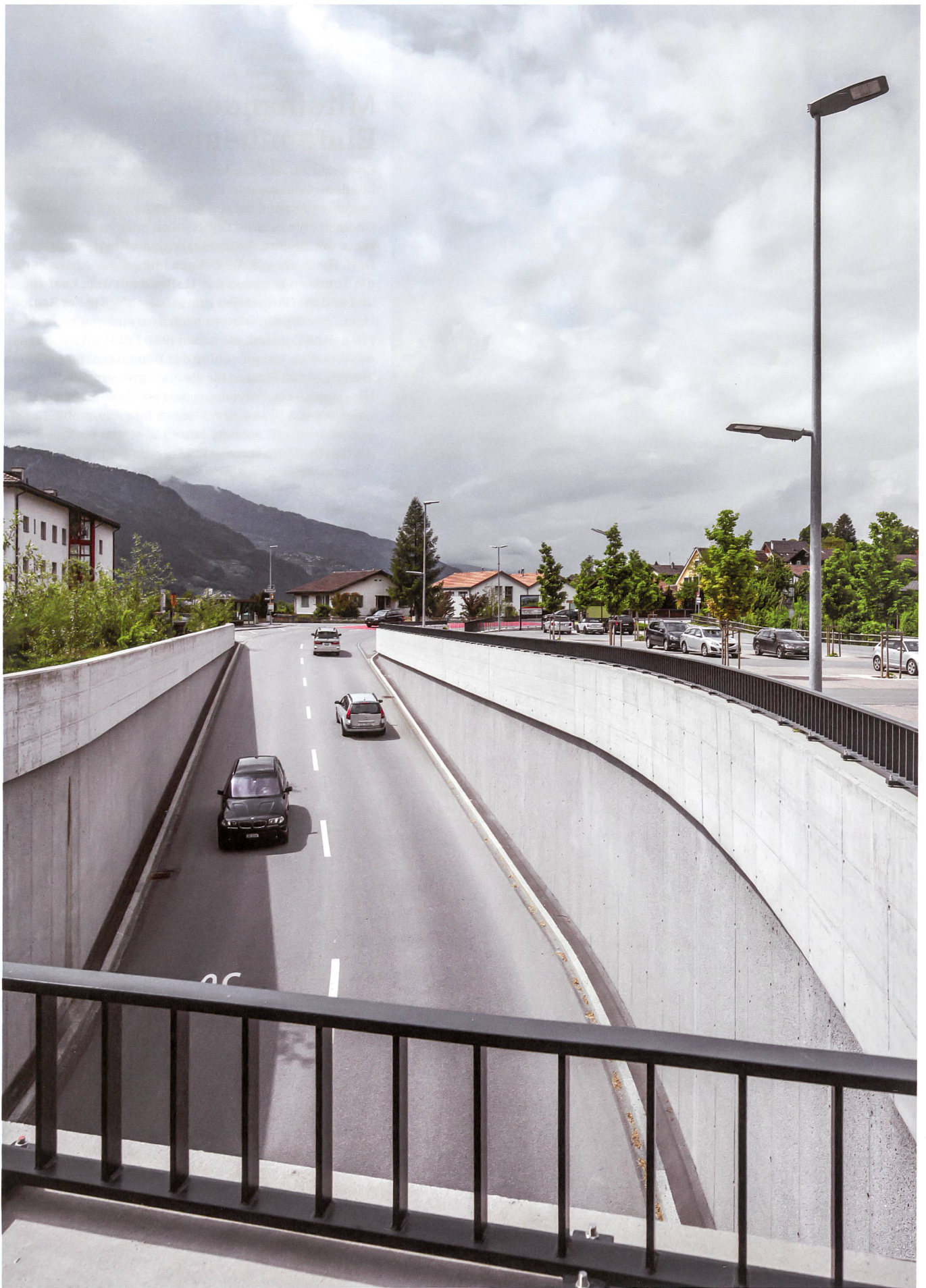
Ist alle Fantasie verloren, geht der Tiefbauer mit Beton in die Landschaft und schafft ein No Man's Land der freien Fahrt für freie Bürger.
