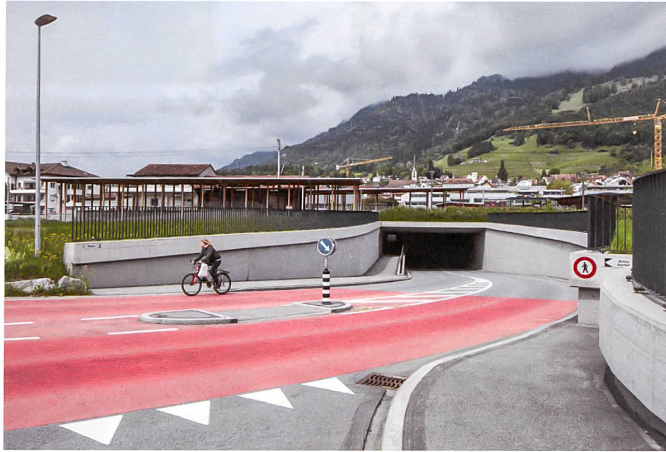
Rote Farbe vor dem Loch soll den Schwung der Autos bremsen, die Fussgänger gehen auf eigenem Weg ins dunkle Loch.
