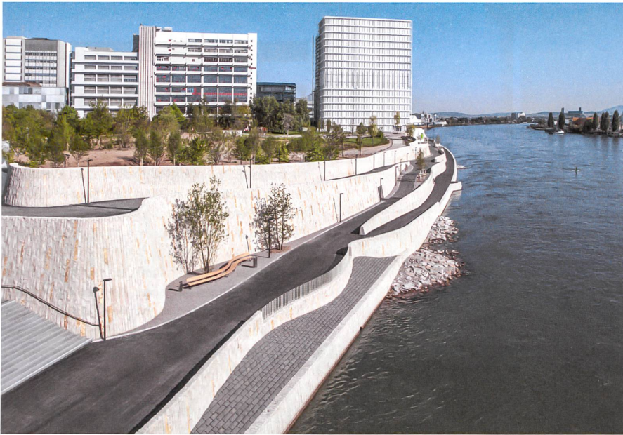
Zwei Promenadenwege führen in Basel dem Rhein entlang: nahe dem Fluss, mit Ausstiegen für Rheinschwimmer, und hoch oben, sicher bei Hochwasser.
