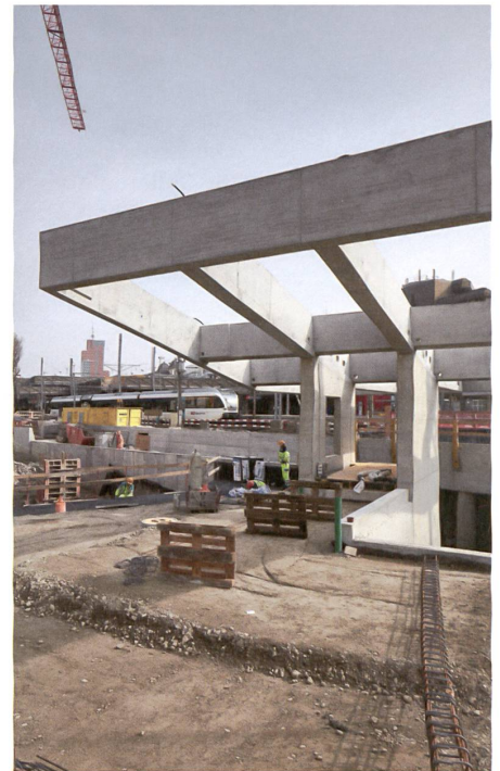
Die Gleisquerung vertet die Verbindung zwischen Altstadt / Bahnhof und Neuwiesenquartier / Sulzer-Areal auf.
