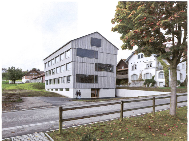
Der Neubau des Kompetenzzentrums Beratung betont mit seinem Satteldach die Hangrichtung.
