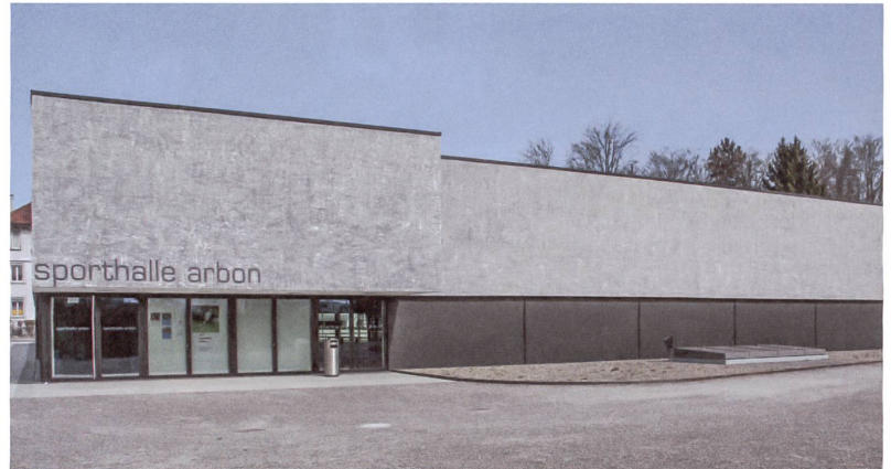
Vor dem Eingang der neuen Dreifachturnhalle auf dem Stacherholzareal in Arbon öffnet sich ein Platz.
