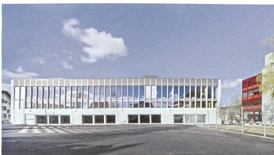
Die Fassade verleiht der aufgestockten Turnhalle ein neues Gesicht.
