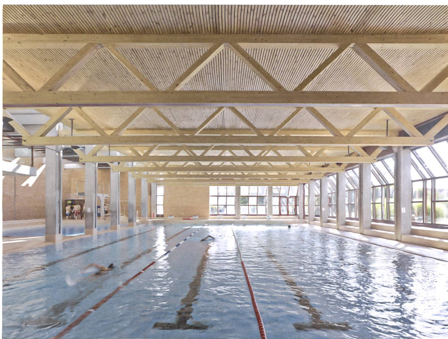
Das sanierte Hallenbad des Berufsbildungszentrums Weinfelden. Ein neues Fachwerk trägt die Decke.
