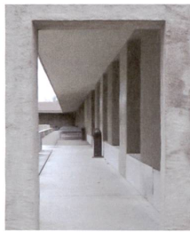
Blick auf den neuen Teil der Mensa durch den wieder geöffneten Mauerdurchbruch.
