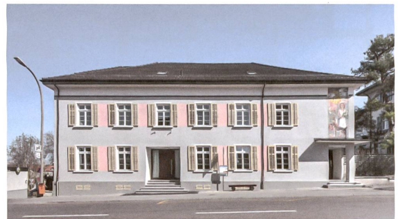
Bezirksgebäude Kreuzlingen: Die Fensterbänder des bescheiden auftretenden Baus wurden farblich zusammengebunden.
