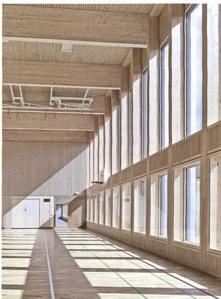
Die Turnhallenaufstockung in Holzelement-Bauweise. Fotos: Jürg Zimmermann
