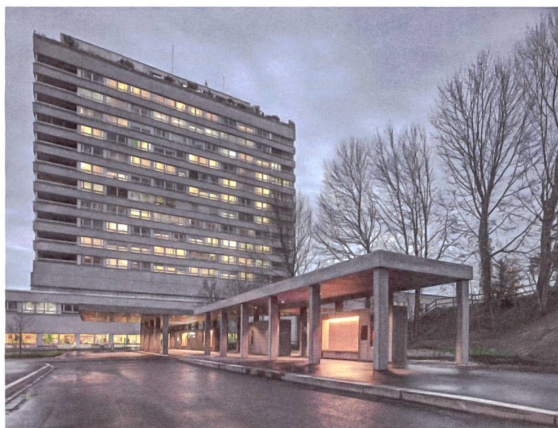
Vor dem Hauptzugang zum Kantonsspital Frauenfeld: Das weit auskragende Dach schützt die Postautopassagiere.
