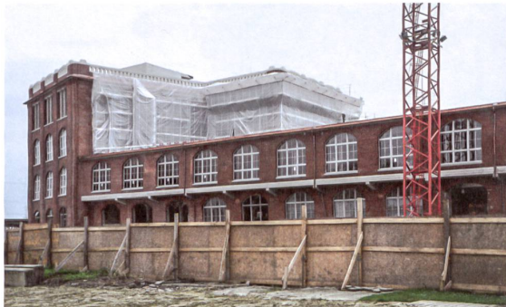
Arbon: Das Hamel-Gebäude wird zu einem Gewerbe- und Wohnhaus umgebaut.
