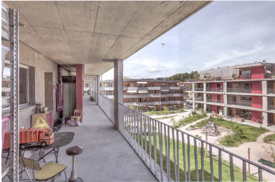
Die autofreie Siedlung in Ostermundigen bei Bern wird durch Laubengänge erschlossen, die wie Balkone nutzbar sind.
