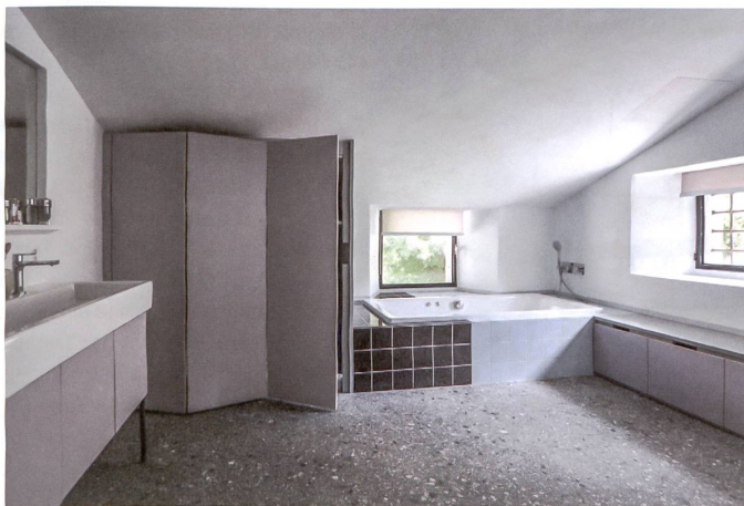
Im Bagno ist die Betondecke geschliffen wie ein Terrazzo. Foto: Alder Clavuot Nunzi
