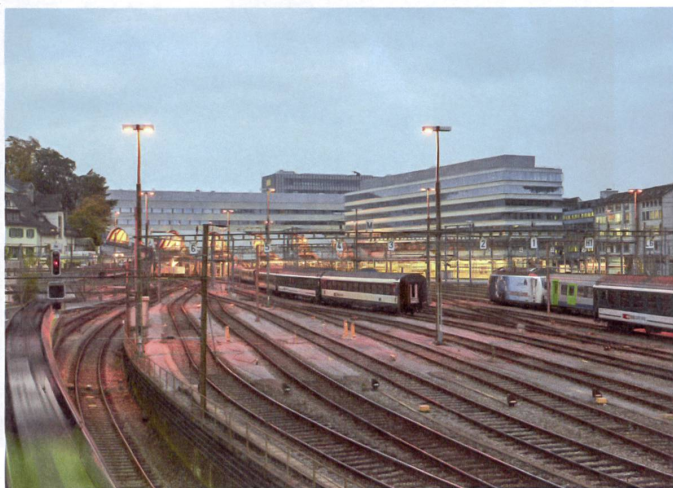
Die drei Kuben des Postparc schliessen den Berner Bahnhof im Westen ab. Fenster- und Brüstungsbänder – einmal schmal, einmal breit – prägen die Fassaden.
