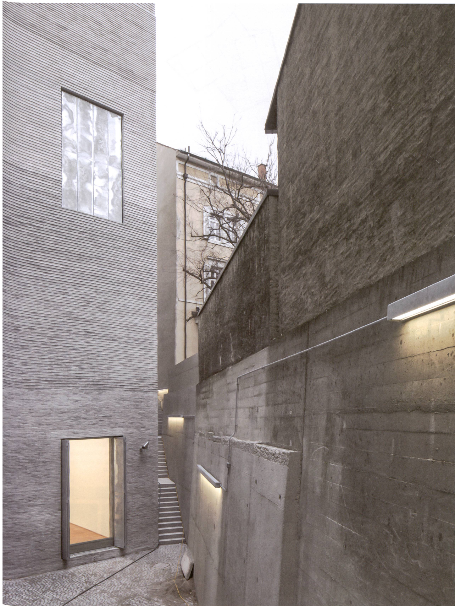
Ihr «Brandmuer-Charakter» verbindet die Fassade des Neubaus mit der direkten Nachbarschaft.
