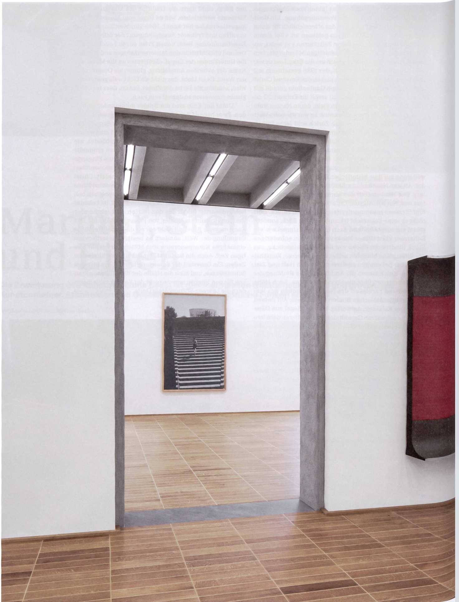
Ausstellungsraum im 1. Obergeschoss: Eichenboden mit Holzzementfugen, Kratzputz und Marmor im Türdurchgang, Gipswände, darüber die Betonelemente der Decke.
