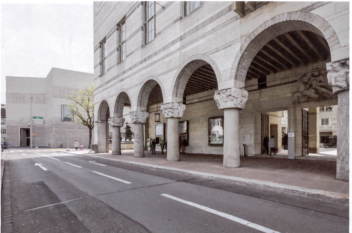
Neu und jenseits der Strasse: Der Erweiterungsbau des Kunstmuseums Basel spricht dieselbe Sprache wie das Haupthaus. Foto: Julian Salinas
