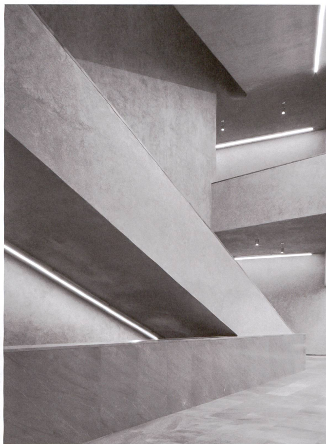
Grauer Stein, grauer Kratzputz, abstrakte Leuchten im Treppenhaus.
