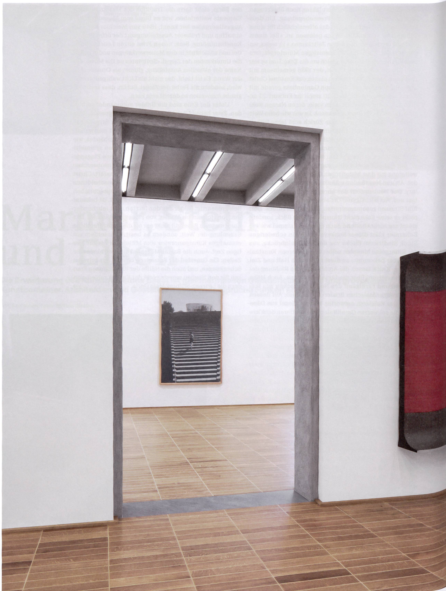
Ausstellungsraum im 1. Obergeschoss: Eichenboden mit Holzzementfugen, Kratzputz und Marmor im Türdurchgang, Gipswände, darüber die Betonelemente der Decke.
