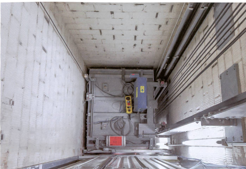
Passt haarscharf: neuer Lift in altem Schacht.
