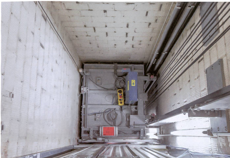
Passt haarscharf: neuer Lift in altem Schacht.
