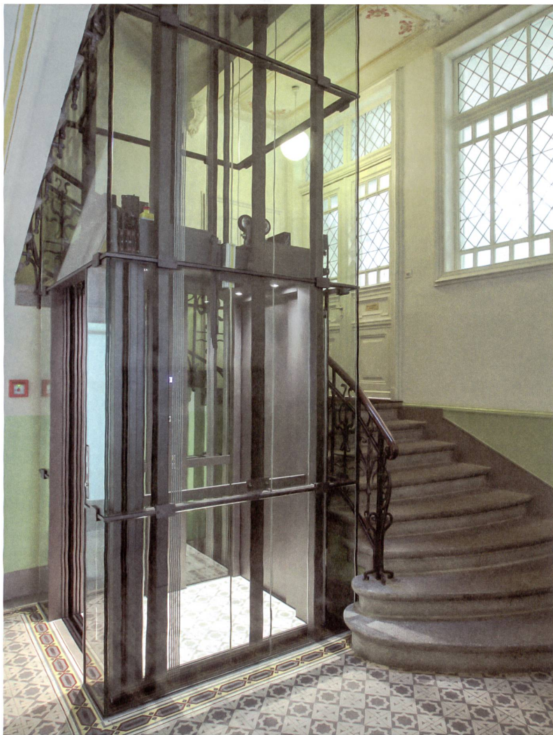
Präzis fügt sich der Lift ins historische Treppenauge.
