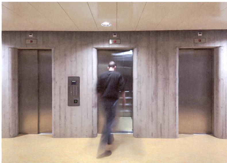
Zielwahlsteuerung heisst: Der Gast gibt sein Ziel auf einem Tableau ein, und die Steuerung weist ihm eine bestimmte Kabine zu.
