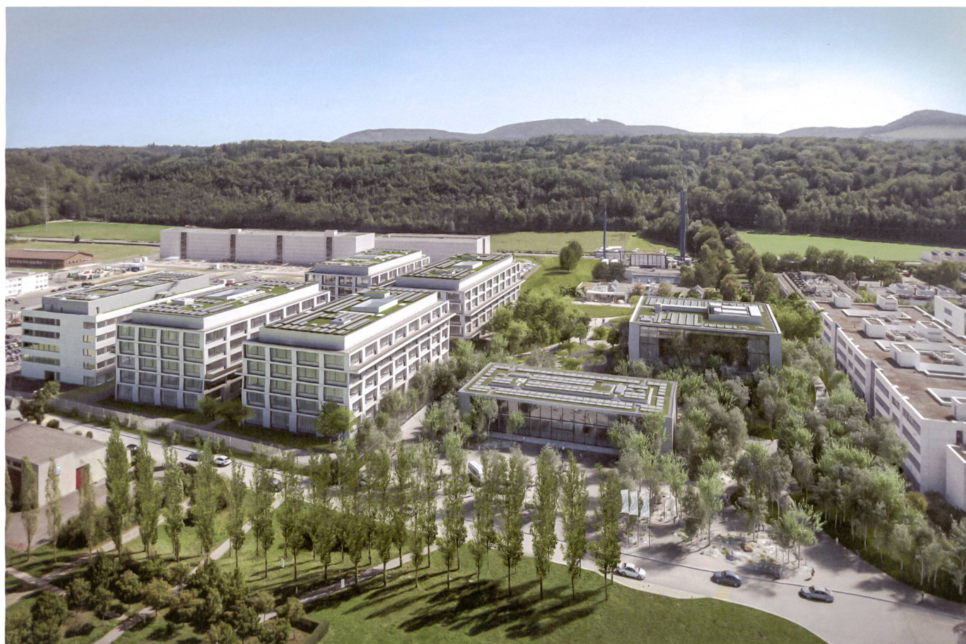
Das Roche-Areal in Kaiseraugst: links die vier Bauten des IT-Innovationszentrums, vorn das Empfangsgebäude, dahinter das Auditoriumsgebäude, rechts die bestehenden Bauten.
