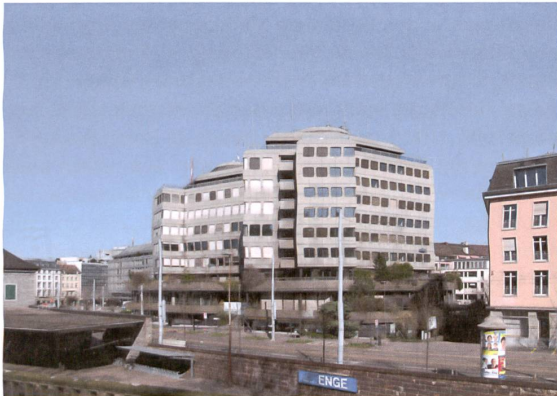
Das Haus von Werner Stücheli vor der Sanierung.
