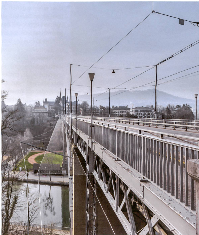
Die Absturzsicherung an der Kirchenfeldbrücke in Bern widerspiegelt die Grosszügigkeit der Brückenkonstruktion.
