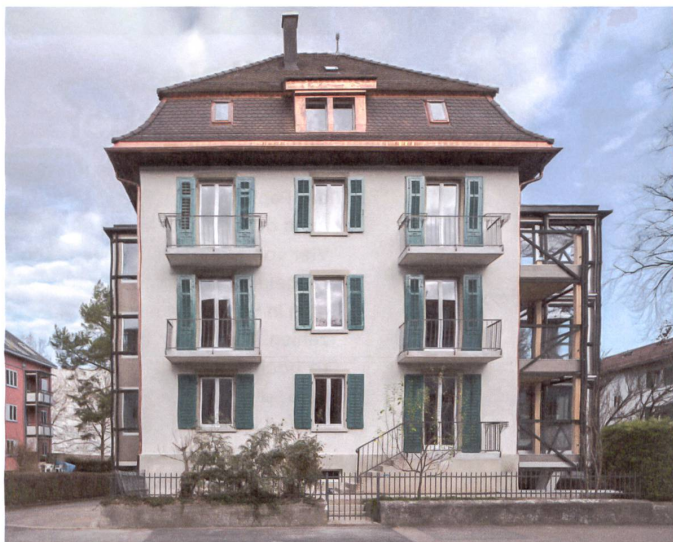
Neue innen- und stadträumliche Qualitäten statt Kuschel-Kontextualität: Auf Dreibeinen aus Beton ziehen zwei Holzbauten das hundertjährige Haus auf 22 Meter Länge.
