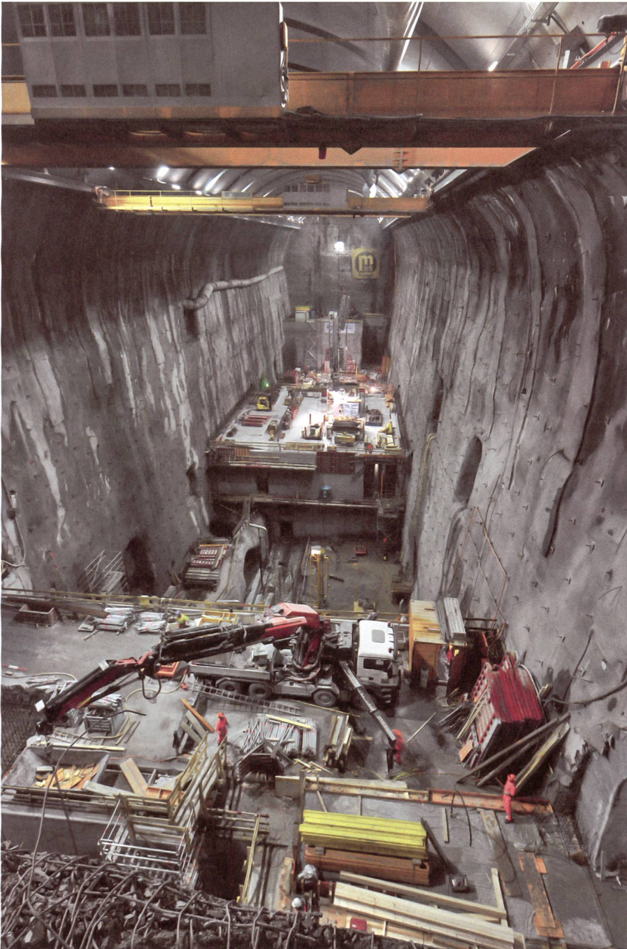
In der Maschinenkaverne auf 1700 Meter über Meer werden Turbinen und Pumpen eingebaut. 150 Meter lang, 53 Meter hoch, 30 Meter breit. Kurz – Platz für das neue Bettenhaus des Triemlispihals Zürich.
