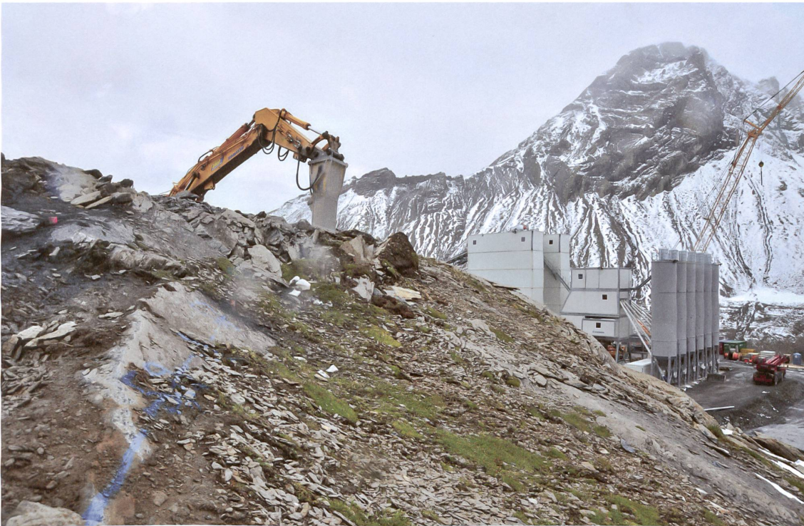
Die Mauerlinie wird markiert. Im Hintergrund steht die Betonfabrik.
