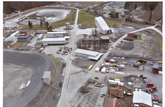
Baustelleninstallation im Tierfehd: Hier beginnt der Feldzug ins Gebirge. Seilbahnen transportieren das gesamte Material in die Höhe.
