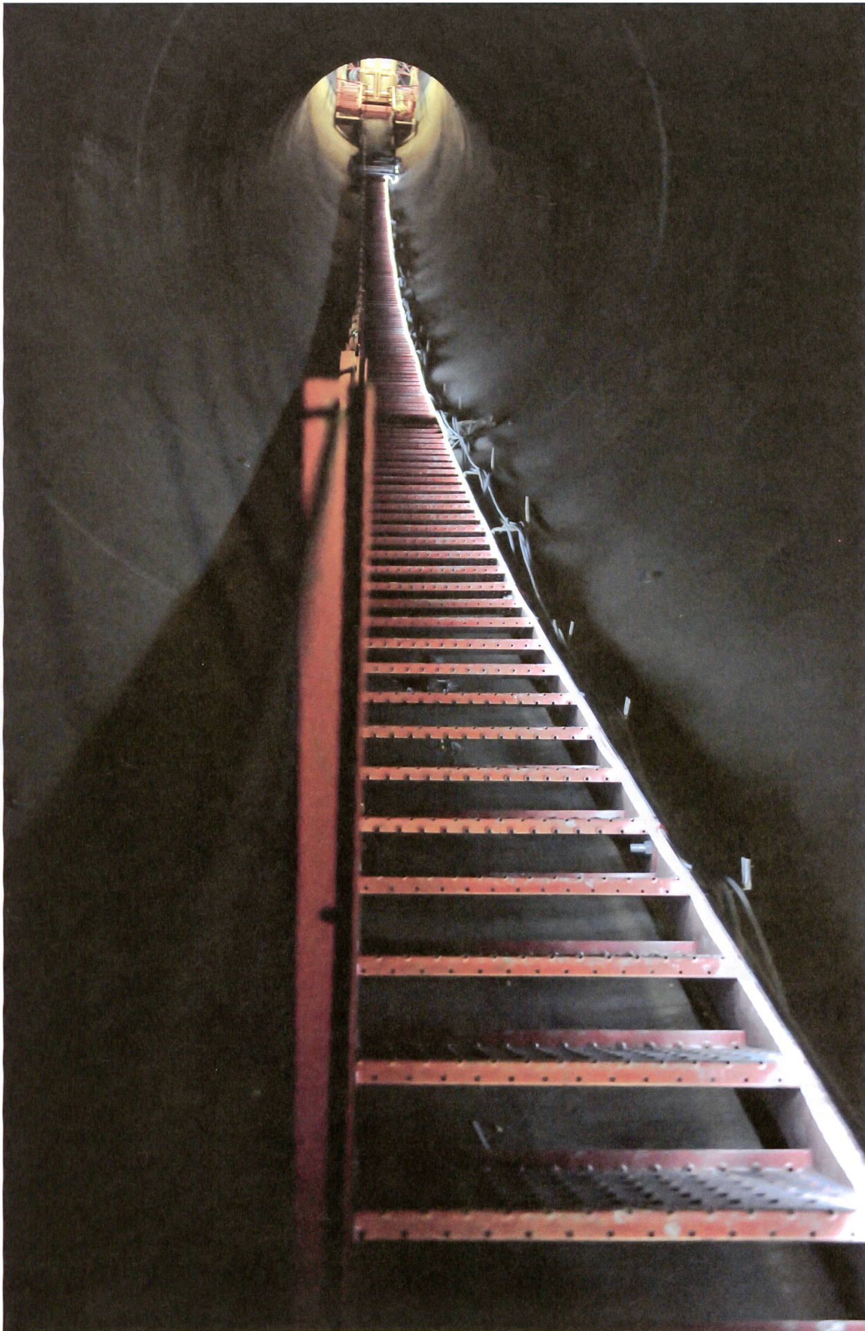
Die Druckleitung für das neue Pumpspeicherwerk «Linthal 2015» im Kanton Glarus ist neunzig Prozent steil. Die Himmelsleiter führt zum Arbeitsort der Schweisser.
