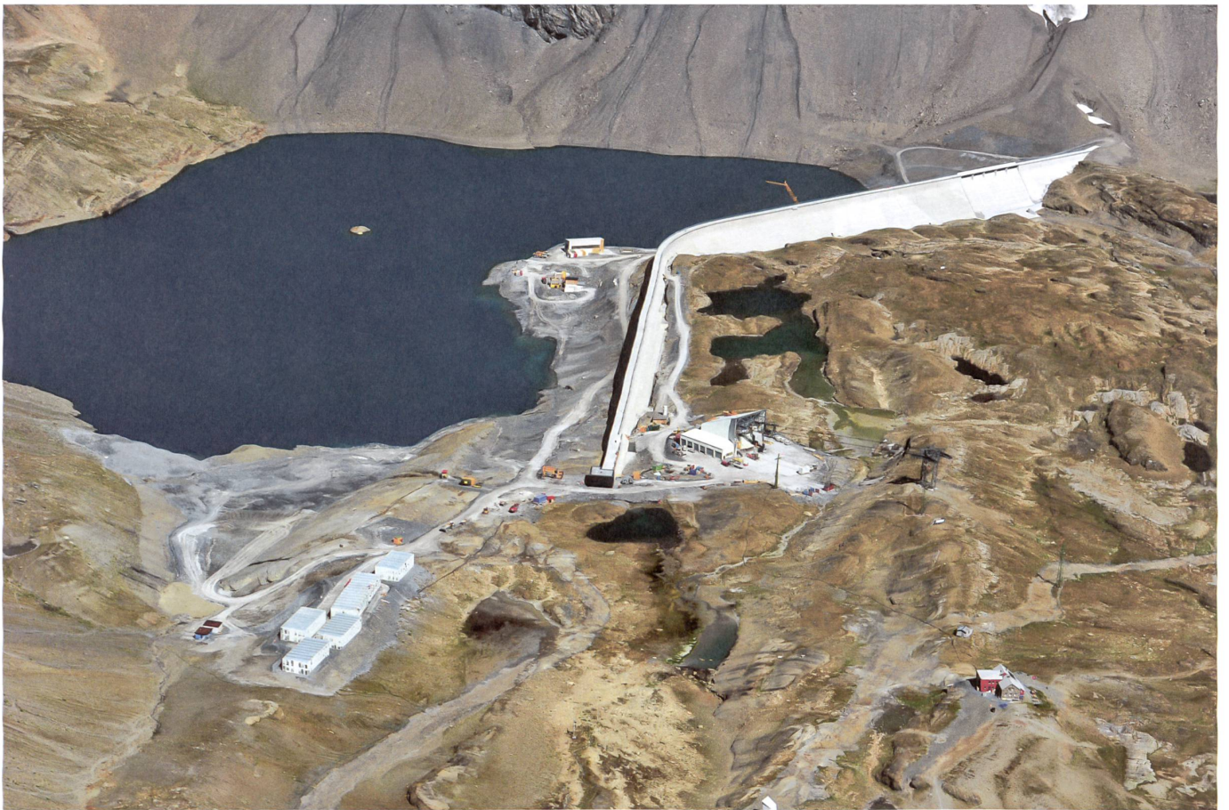
Die Staumauer des Pumpspeicherwerks «Linthal 2015» ist 35 Meter hoch und mehr als 1000 Meter lang. Das Volumen des Muttsees steigt von 9 auf 25 Millionen Kubikmeter. Bauseilbahnen und Betonwerk werden aufgebaut. Links unten das Barackendorf für 100 Arbeiter – sie taufen es Guantanamo.
