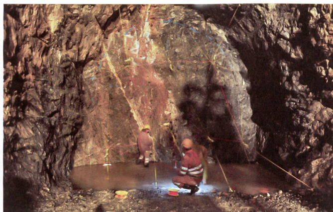
Die Zugangsstollen werden bergmännisch ausgebrochen.
