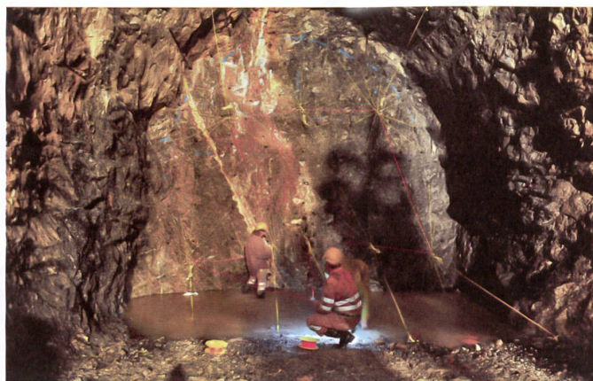
In der Maschinenkaverne auf 1700 Meter über Meer werden Turbinen und Pumpen eingebaut. 150 Meter lang, 53 Meter hoch, 30 Meter breit. Kurz – Platz für das neue Bettenhaus des Triemlispihals Zürich.
