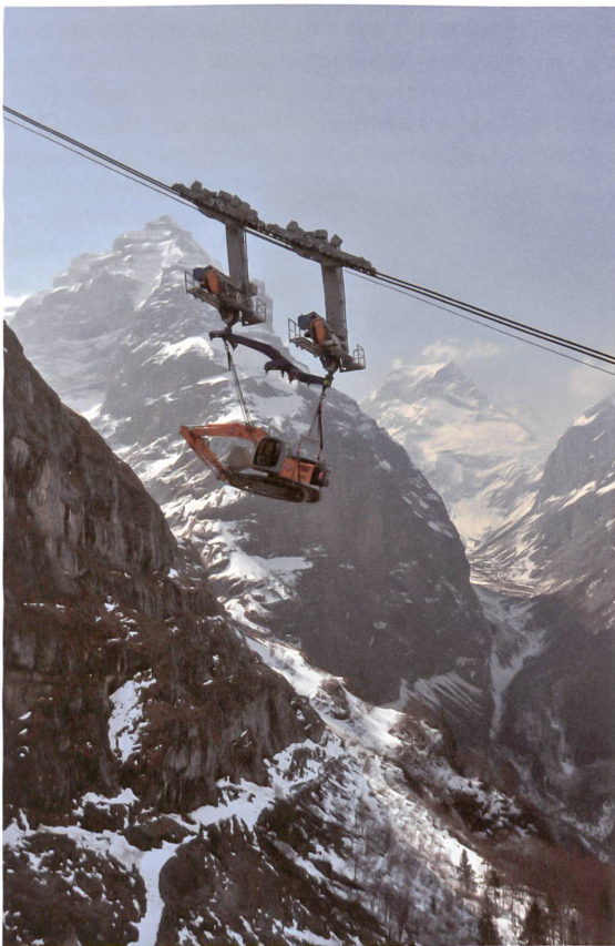
Ein Bagger hängt an der Bauseilbahn 1 von Tierfehd nach Chalchtrittli. Sie hat eine Nutzlast von vierzig Tonnen und läuft rund um die Uhr.
