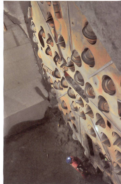
Tunnelbohrmaschine: 8 Meter Durchmesser, 160 Meter lang, 1500 Tonnen schwer.
