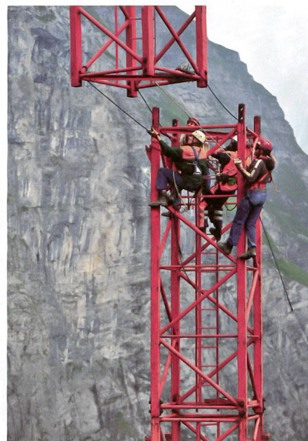
Kranbau mit Helikopter auf der Baumgartenalp für die Stütze 1 der Bauseilbahn.
