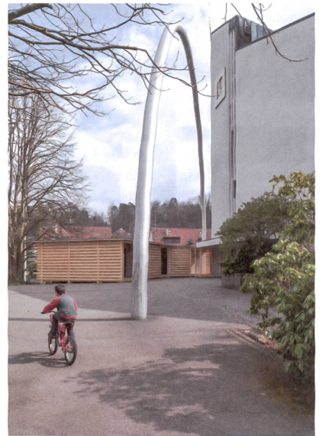
Mit Holz verkleidete Sanitärcontainer vor der Kirche Rosenberg in Winterthur.
