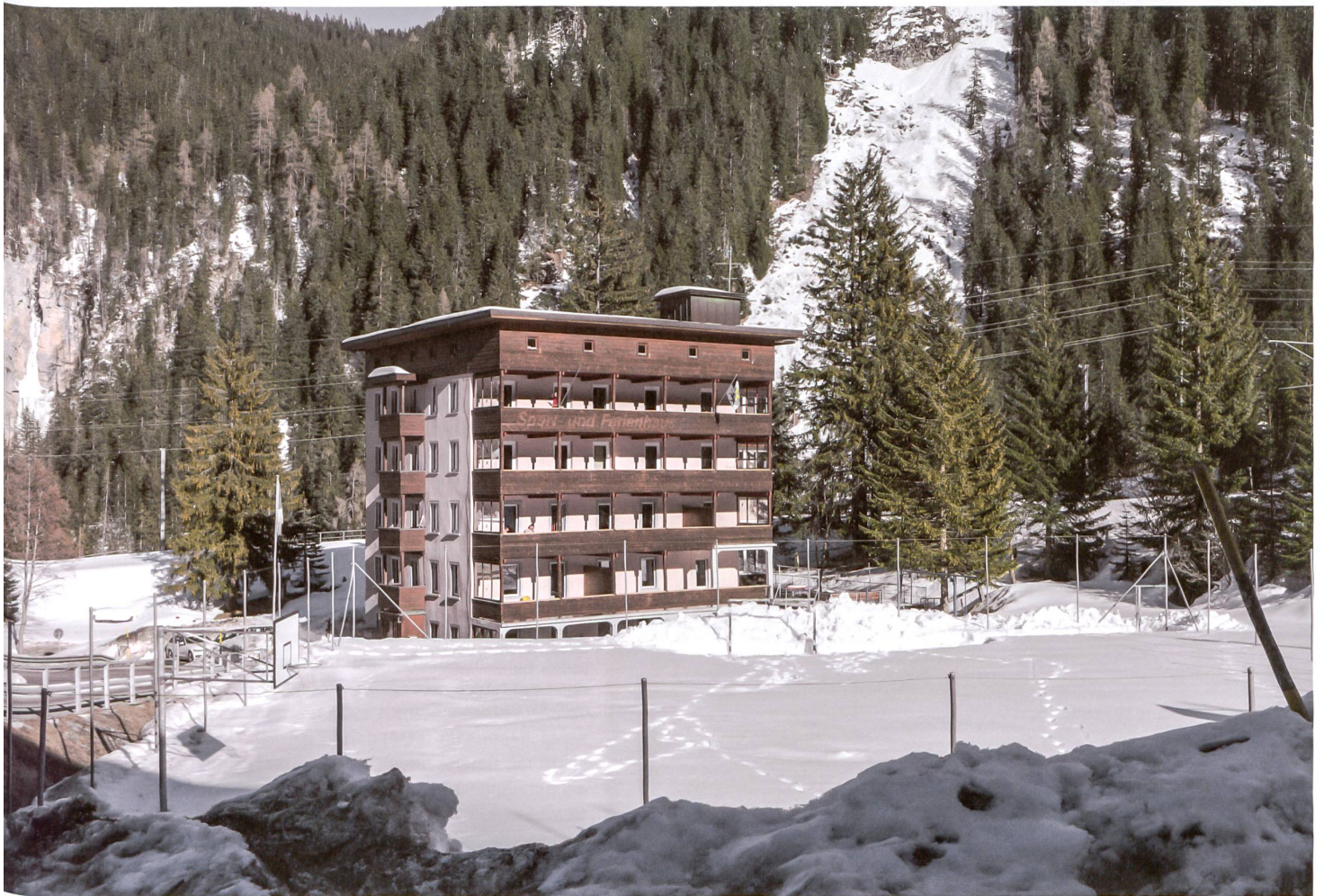
Das ehemalige Sport- und Ferienhaus Valbella in Litzirüti bietet Platz für hundert Asylbewerberinnen.
