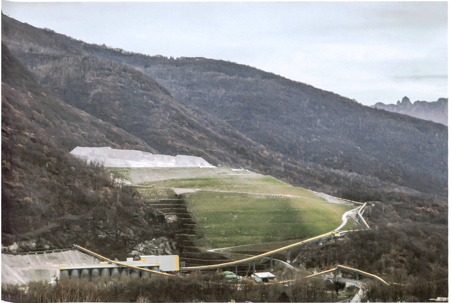
3,5 Millionen Kubikmeter Felsausbruch schichten sich zur Materialablagerung in Sigrino.
