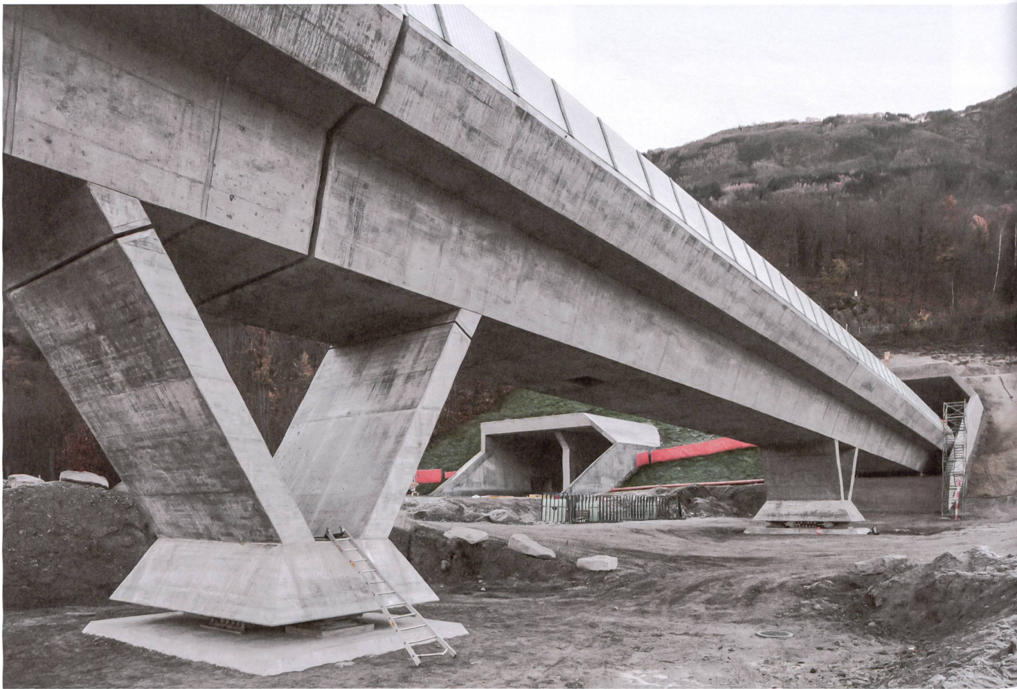
Kräftige Beine: Die V-Stützen des Viadukts bilden mit der Brückenplatte ein kraftschlüssiges Dreieck wider die Bremslast der Züge und verkürzen die Spannweite.
