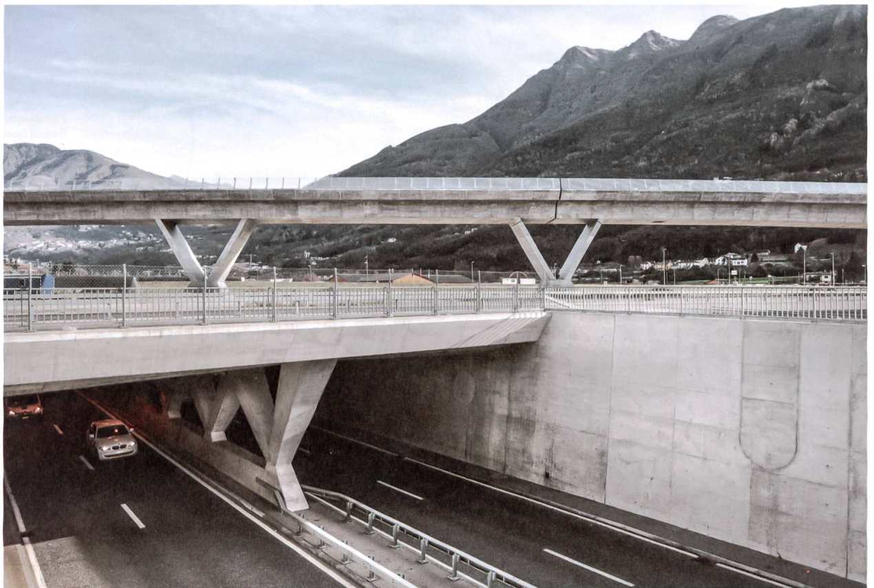
Kohärente Formen: Bei Camorino bezieht sich die aufgelöste Mittelwand der Kantonsstrassenunterführung erkennbar auf die Stützen des Viadukts.
