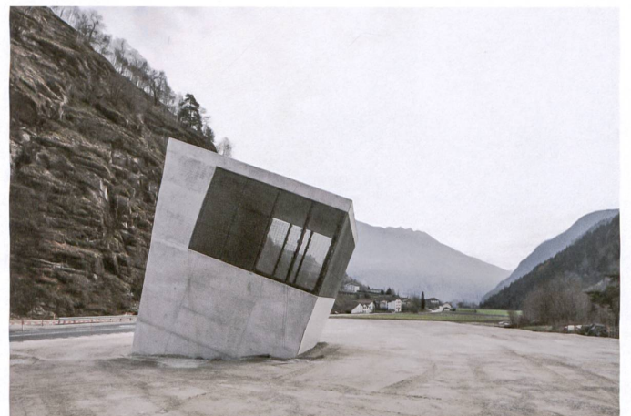
Um ein Wiederansaugen von Abluft zu verhindern, stösst der Zuluftkanal separat an die Oberfläche.
