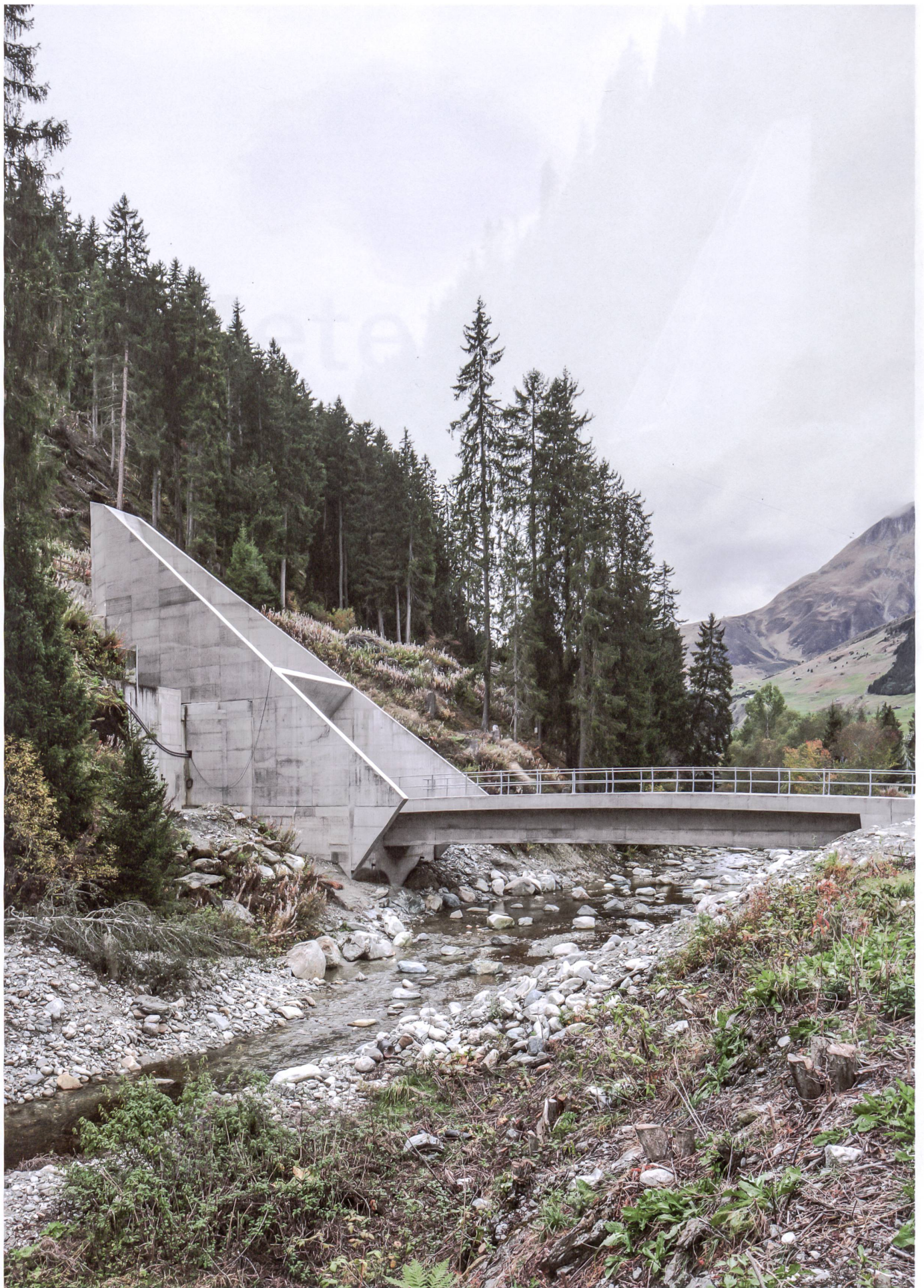
Multifunktionale Zufahrt: Das Portalbauwerk bei Sedrun verbindet Zuluftkanal, Lawinenschutz und Zufahrt zu den 800 Meter tiefen Schächten im Berginneren.
