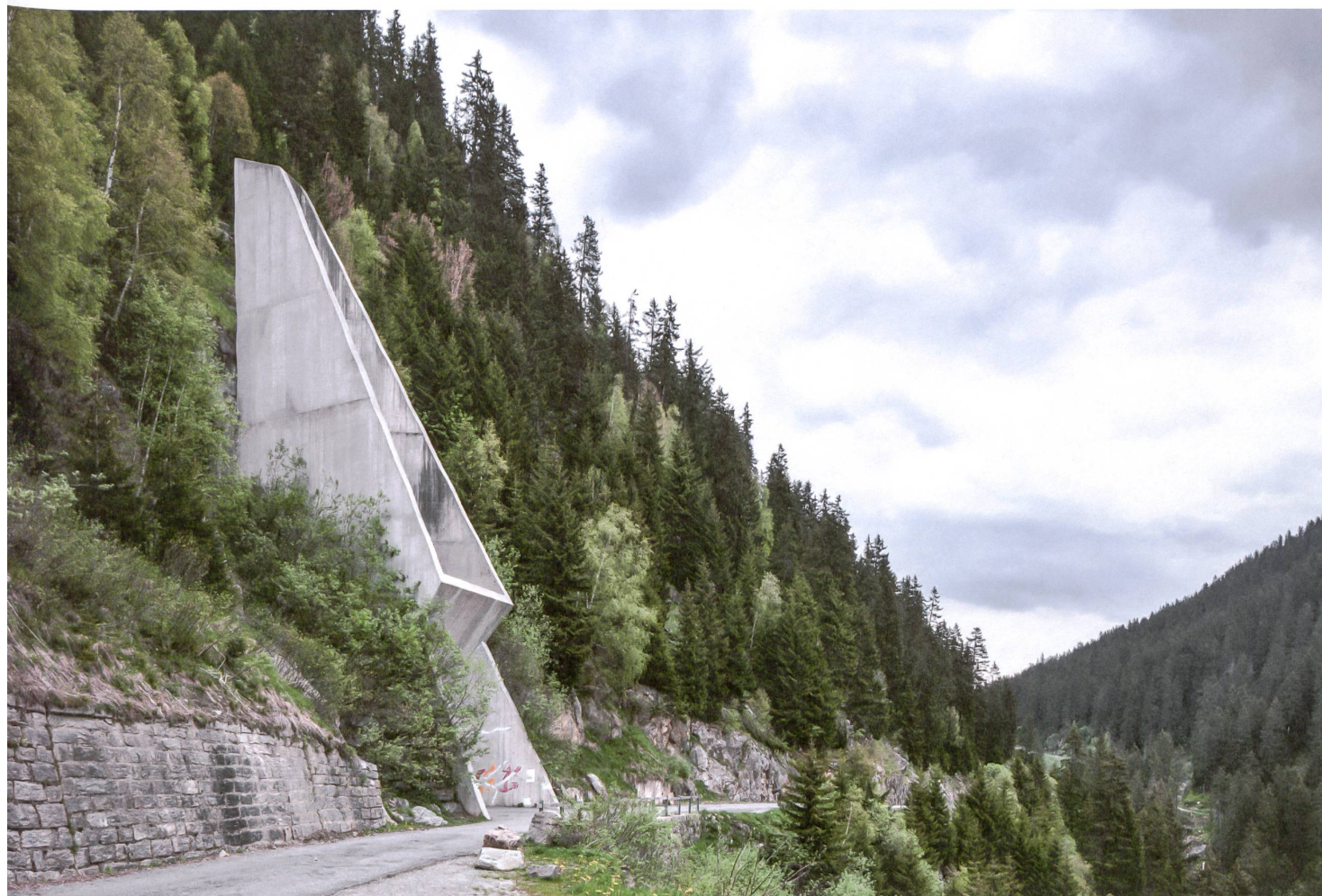
Integrative Form: Der Entlüftungsbau in Sedrun vereint Abluft, Lawinenschutz, Zugang und Wendeplatz.
