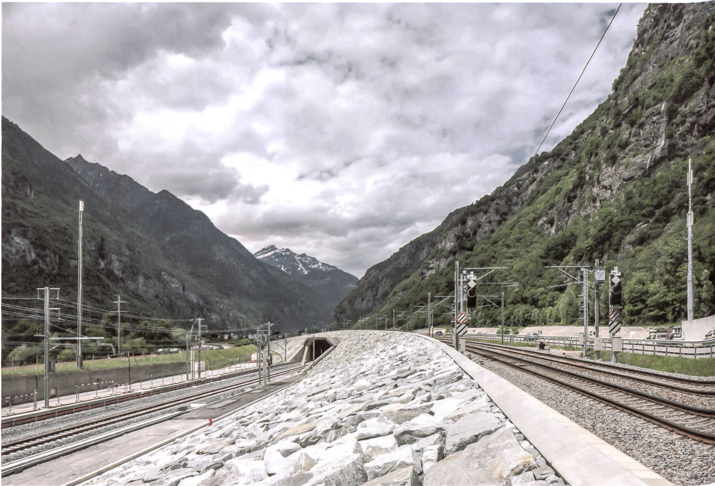
Südliche Portallandschaft bei Bodio: Analog zum Norden führt die Stammlinie als Granitsichel in weitem Schwung über die neue Flachbahn.
