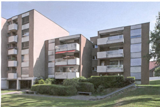
Die Häuser wurden nie umfassend saniert.
