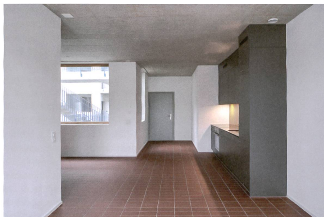
Einfache Materialisierung mit Plattenboden, Abrieb und Sichtbeton.
