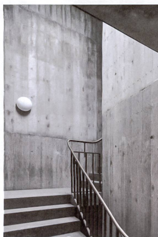
Beton mit Bretterschälung im Treppenhaus.
