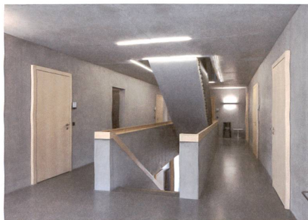
Massive Brüstungen im 1. Obergeschoss.
