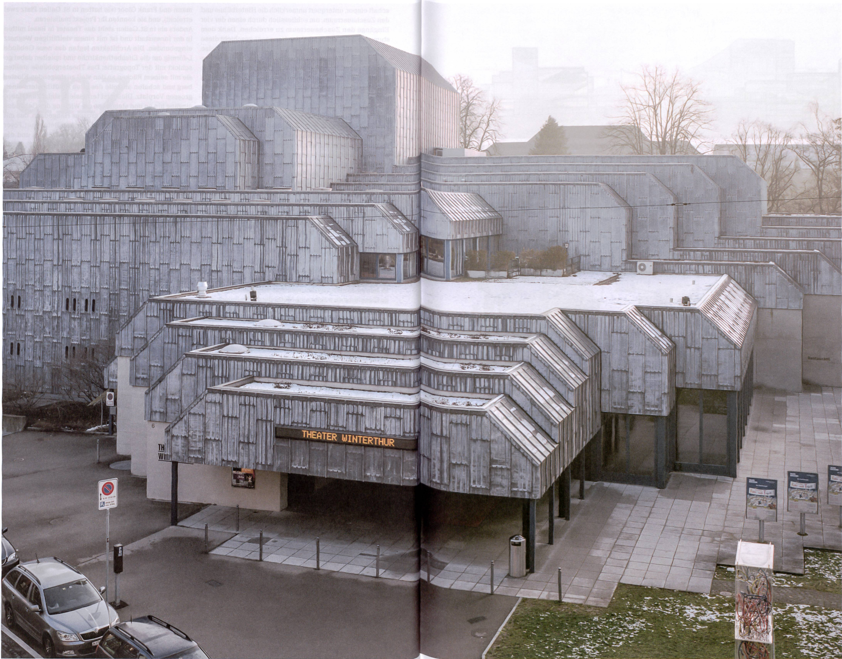
Architekt Frank Krayenbühl staffelte das Theater Winterthur in Grundriss und Schnitt vielstufig ab und hüllte es in eine dicke Haut aus Blei. Die Leuchtschrift, die diese Haut schmerzlich ver- letzt, ist eine spätere Zutat. Foto: Susanne Heftl
