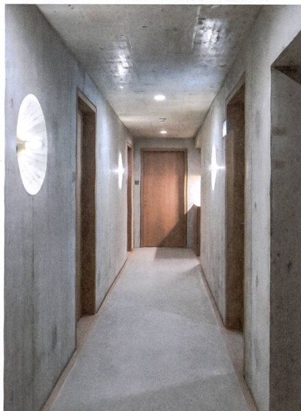
Der Korridor im neuen Hinterhaus. Indem der Boden rundum mit einer Leiste aus Eichenholz eingefasst wird, wirkt der Beton wie ein edler Läufer. Die Formen für die direkt in den Beton gegossenen Leuchten- schirme fabrizierten die Architekten eigenhändig in ihrem Büro aus Styropor.
