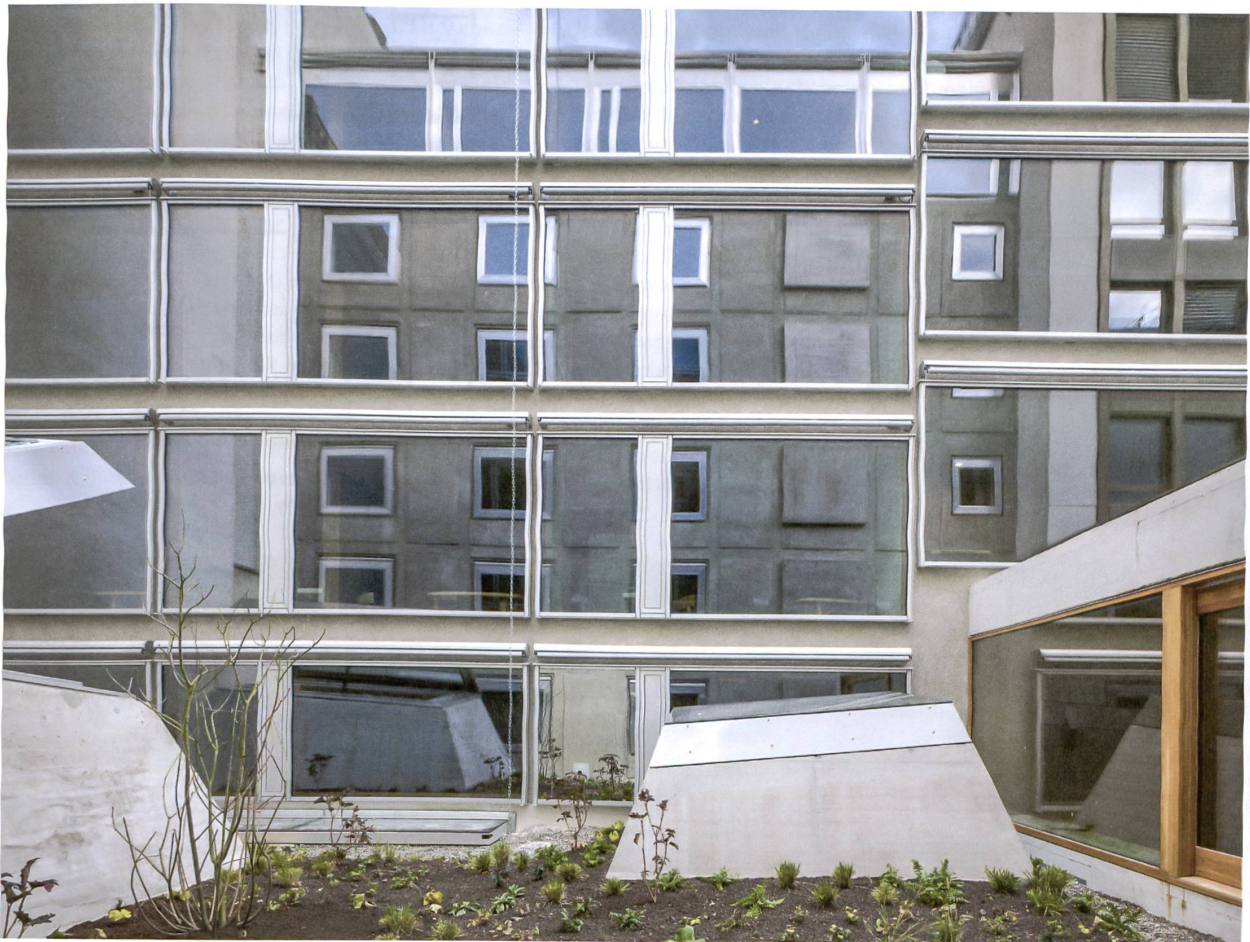
Zwischen den beiden Gebäudeteilen ist auf der Höhe des ersten Geschosses ein begrünter Aussenraum entstanden. Hier spiegeln sich die Aluminiumfenster des renovierten Vorderhauses in den Fenstern des Neubaus.
