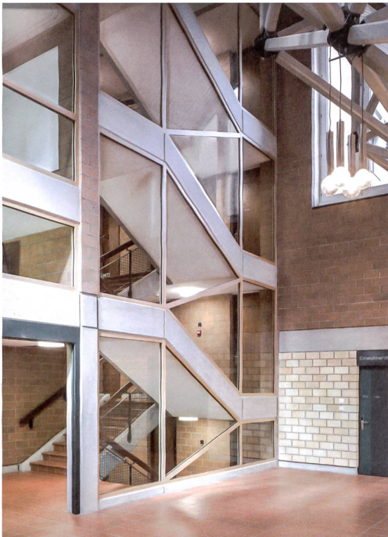
Die Eichenprofile der neuen Verglasung bringen Bewegung ins Treppenhaus. Hinter den Fenstern links befinden sich neue Besprechungsräume.
