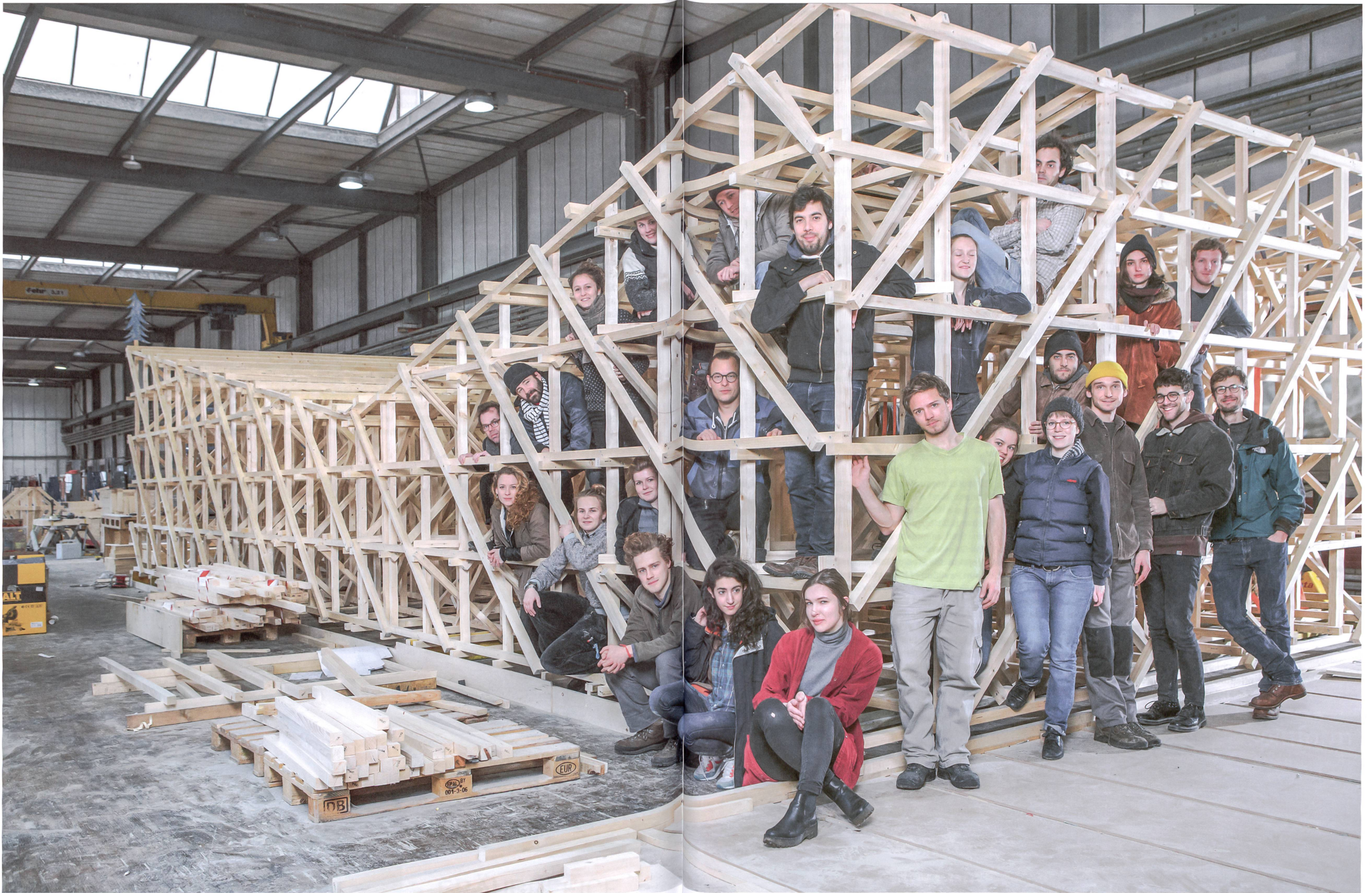
Ein Dachelement für den Manifesta-Pavillon wächst in Winterthur: ETH-Studierende von Tom Emerson entwerfen, planen und bauen die Holzkonstruktion selbst siehe Seite 24.
