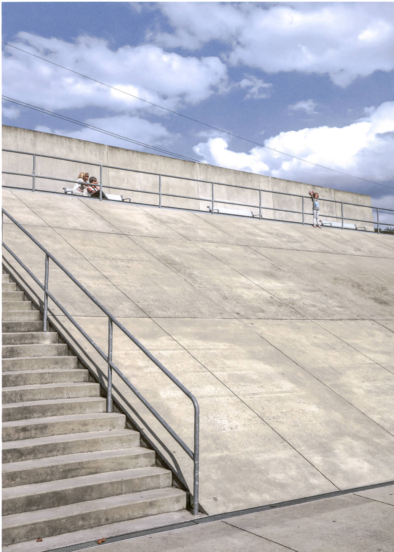
Die Rampe am Nordrand des Parks ist auch Aussichtsplattform: Sie besteht aus dem Aushub des Sees und schützt gleichzeitig vor dem Autobahnlärm.
