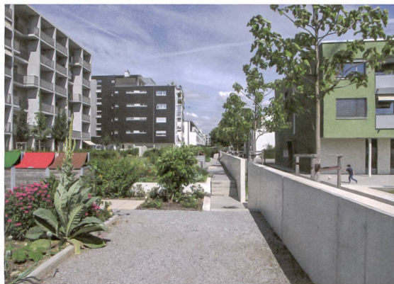
Grünräume als Pendant baulicher Verdichtung. Wohnsiedlung Futura von Ecofaubourgs in Schlieren.
