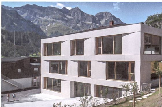
Neues Schulhaus in Engelberg: Südostfassade mit Hof und Eingang.
