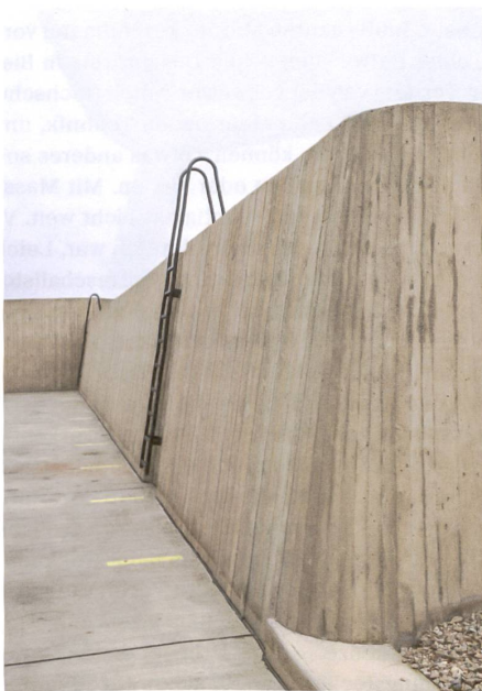
Zwei Schalungstexturen: Das Kraftwerk und die Brücken zeigen Spuren geordneter Schalungstafeln, die Stützmauern und Brückenaufleger überzieht das Abbild verschieden breiter, sägerhoher Bretter.
