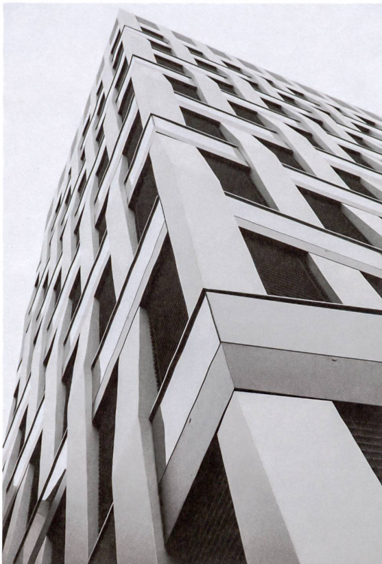
Das Fassadengeflecht aus der Nähe. | Détail du tressage de la façade.
