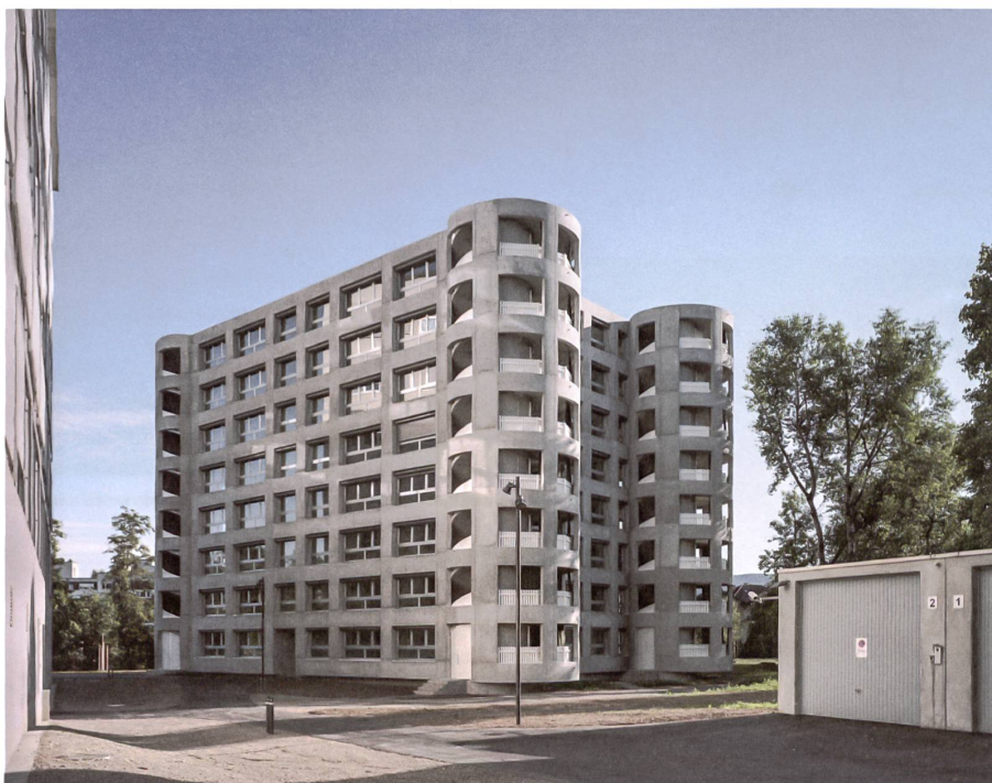
Die «Burg» im Zellweger-Park in Uster irritiert: Die schwere Betonfigur scheint über dem Boden zu schweben.
