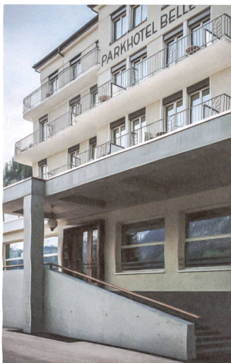
Das Parkhotel Bellevue in Adelboden ist einer der wenigen Hotelbauten der Moderne in der Schweiz.
