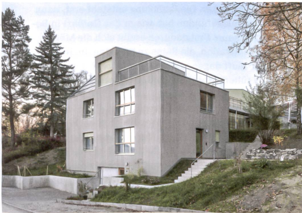
Wohnsiedlung Lätthübel, Erlinsbach schaeerholzbau: Gesamtleister mit Werkgruppe
