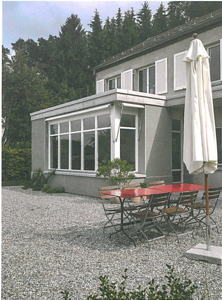
Unscheinbar schiebt sich die neuartige Verbundkonstruktion aus Sandstein, Dämmung und Beton als Wohnraumerweiterung in den Garten des Einfamilienhauses von Emil Roth.
