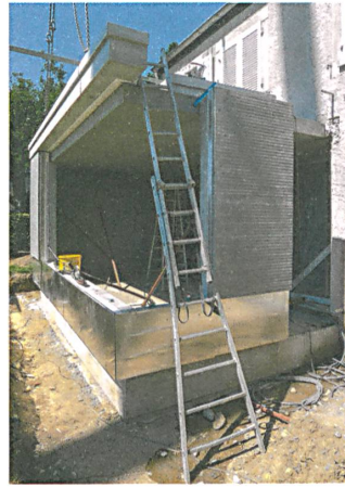
Auch die Deckenplatte und das profilierte Sims sind aus Beton vorfabriziert.
