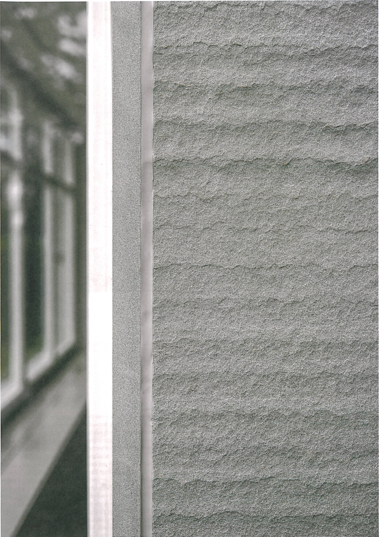
Der geflammte Rorschacher Sandstein schützt und trägt als Teil einer Verbundkonstruktion eines Anbaus in Obfelden.
