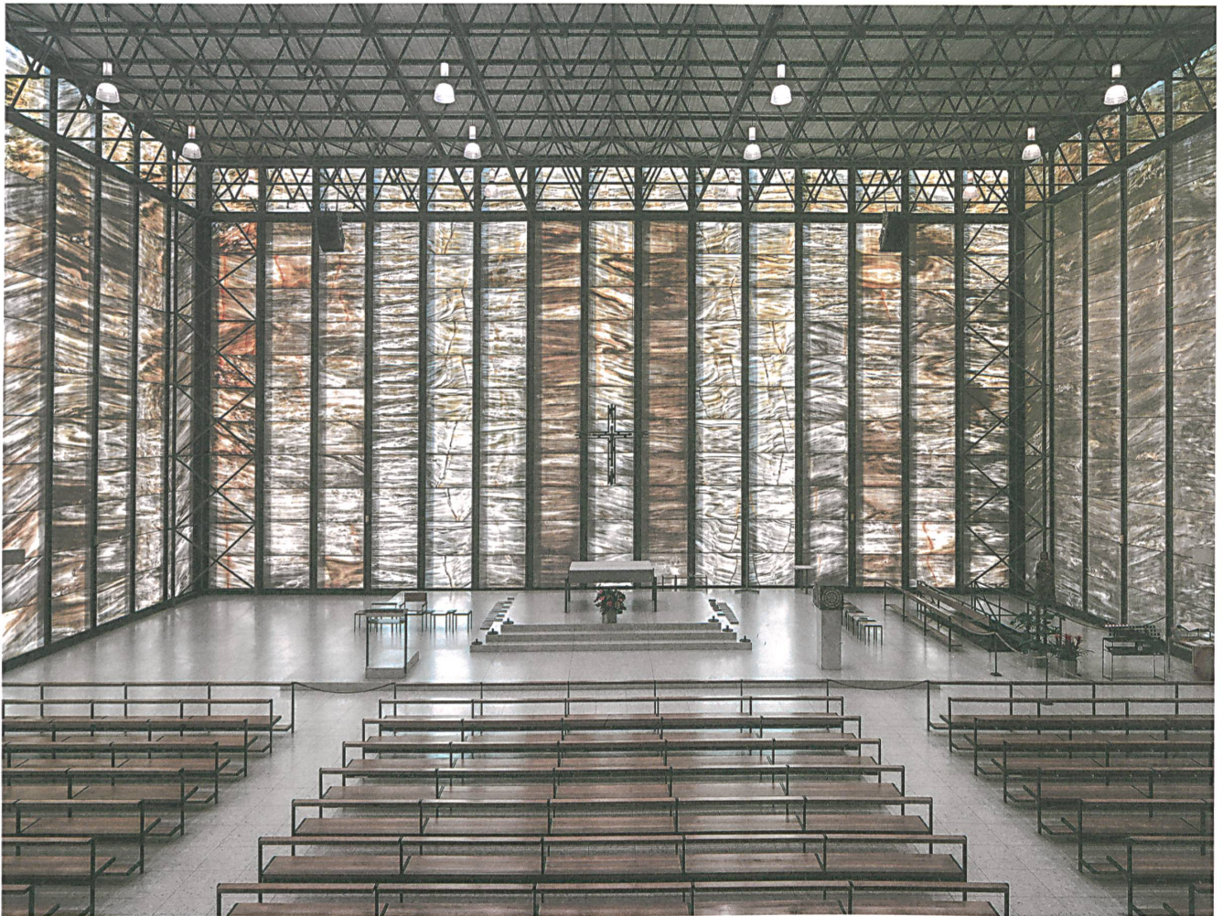
Konstruktion pur: 28 Millimeter dünne Platten aus Dionysos-Marmor liegen als atmosphärische Lichtfilterschicht zwischen den Stahlstützen des streng rhythmisierten Baus.
