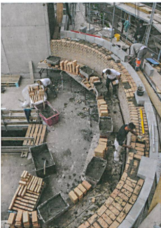
Zeitgleich zogen Maurer und Versetzer die Verbundkonstruktion hoch.
