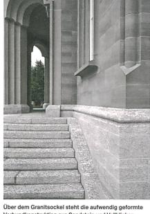
Verbundkonstruktion aus Sandstein und Vollklinker.
