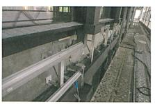
Die Fassade während der Sanierung: Schienen der Hinterschnittkonstruktion.
