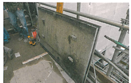
Steinplatten mit Agraffenhalterung.
