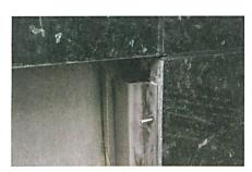
Die Fassade vor der Sanierung: Seitliche Metallstifte halten die Steinplatten.
