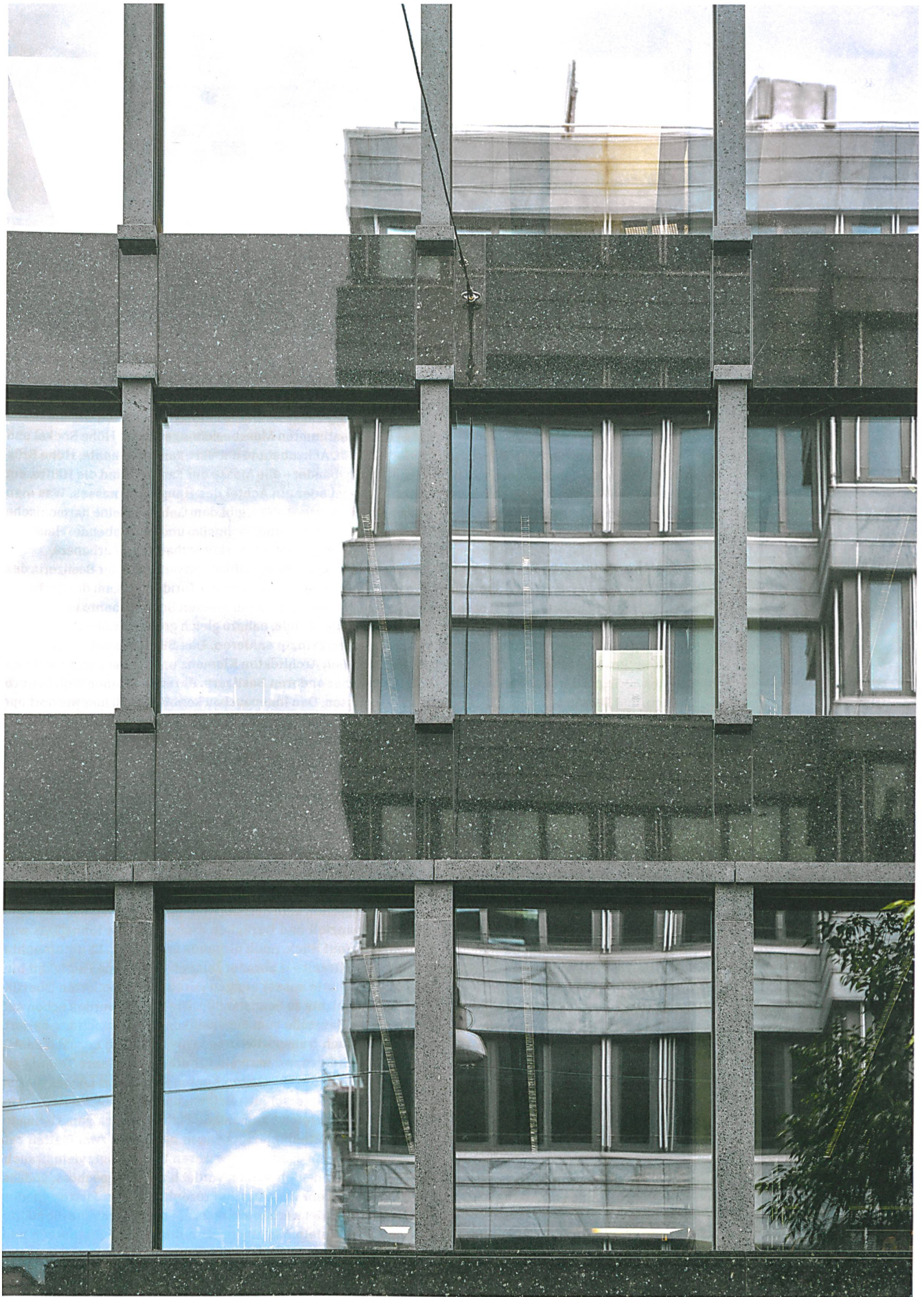
Bürohaus am Bleicherweg in Zürich: Die Granitplatten sind alt, die helleren Kunststeinelemente neu.
