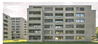
Sozialer Wohnungsbau in La Chapelle-Lancy Bassicarella Architectes
