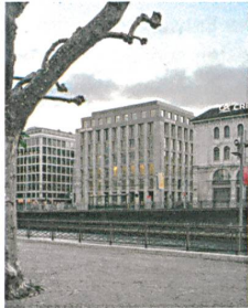
Umbau Credit Suisse Bel-Air in Genf Buchner Bründler Architekten
