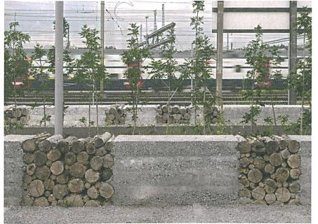
$\label{thm:model} \mbox{Umgebung Letzibach in Z\"{u}rich-Altstetten: Holzst\"{a}mme \mbox{f\"{u}r Kleinlebewesen sind in Stampfbetonmauern eingelassen.}$
