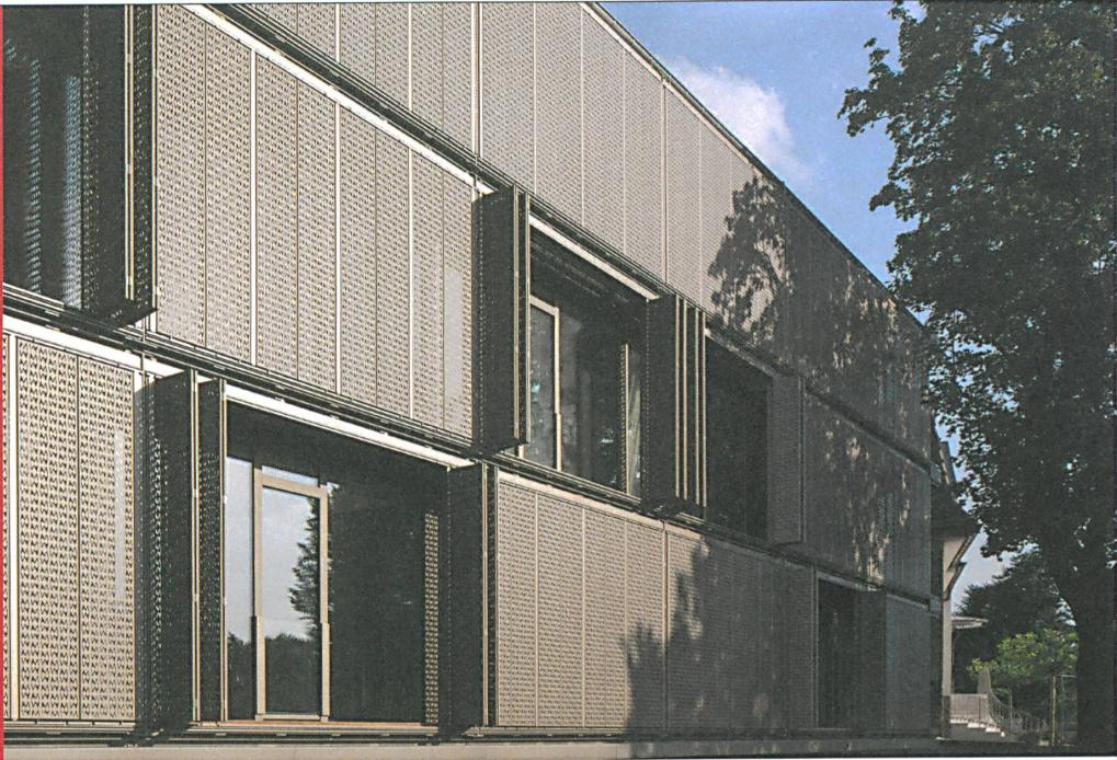
Das automatisierte Beschlagsystem für frontbündige Faltschiebeläden HAWA-Frontego 30/matic bietet individuellen Sicht- und Sonnenschutz und gleichzeitig mehr Sicherheit. Der energiesparende Antrieb und die Steuerung sind im System integriert.
