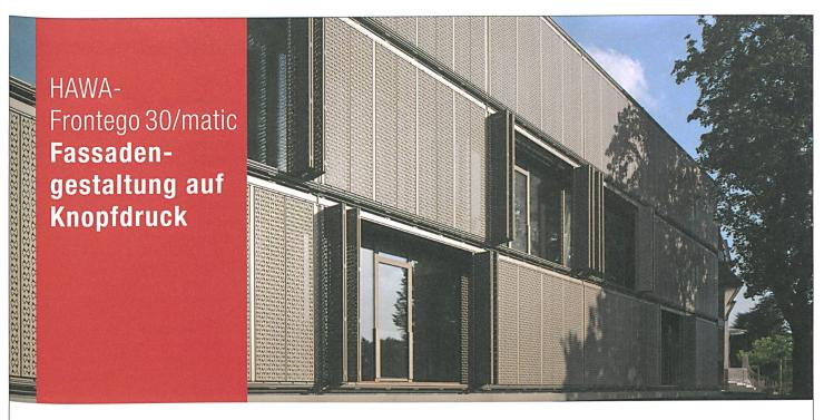
Das automatisierte Beschlagsystem für frontbündige Faltschiebeläden HAWA-Frontego 30/matic bietet individuellen Sicht- und Sonnenschutz und gleichzeitig mehr Sicherheit. Der energiesparende Antrieb und die Steuerung sind im System integriert.
