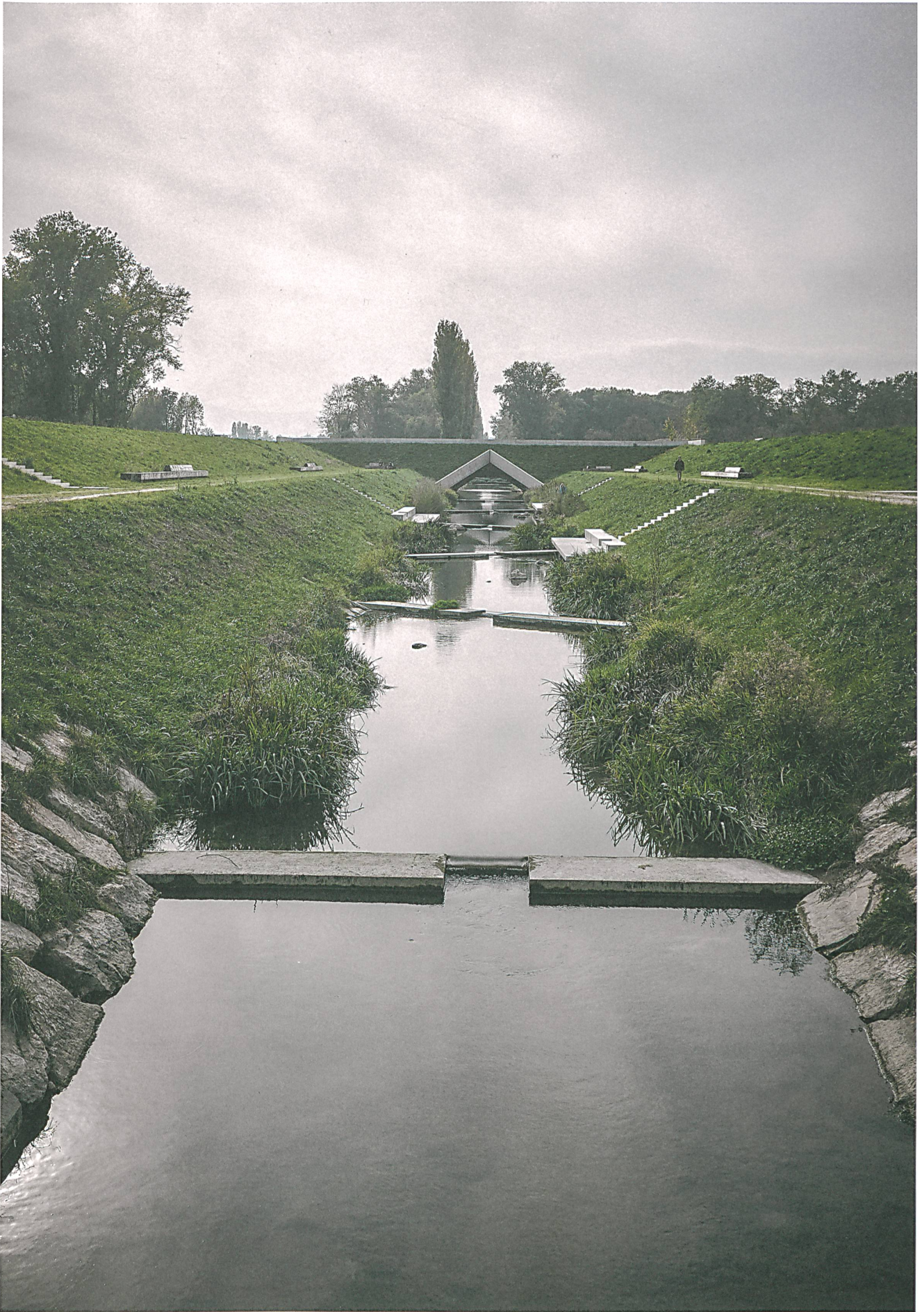
Der neue Damm bei der Autobahn in der Nähe von Confignon bei Genf soll das Hochwasser zurückhalten. Da dient der alte Kanal auch noch als Auffangbecken.
