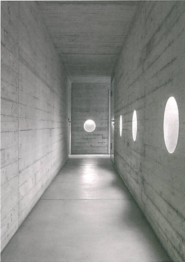
Damit sie nicht blenden, sind die Leuchten unterhalb der Kopfhöhe platziert.
